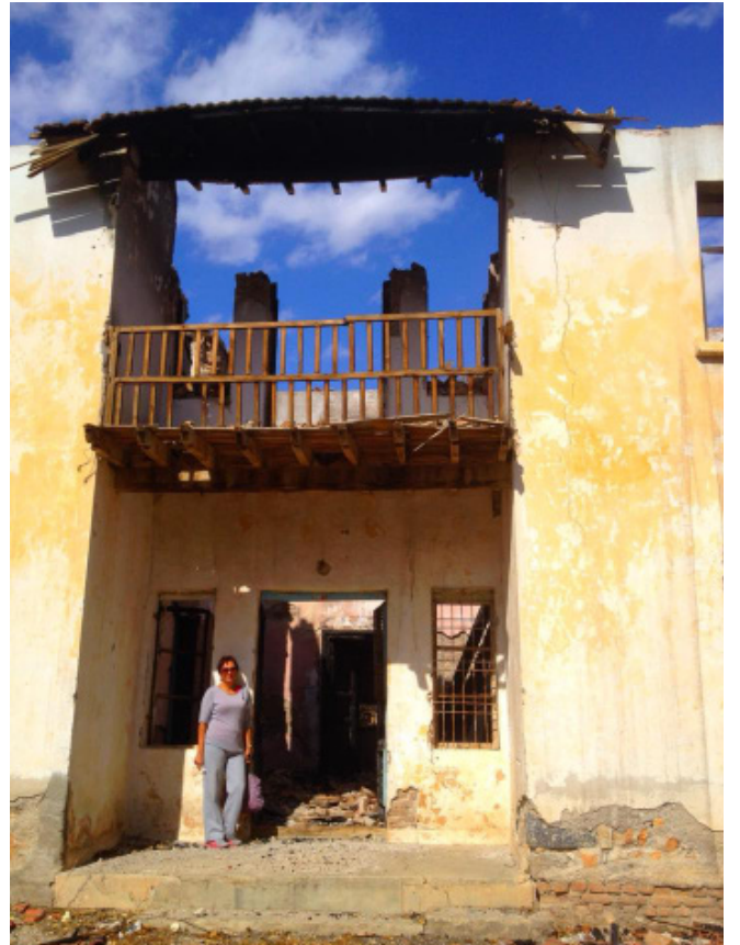
Akçadağ Köy Enstitüsü Yerleşkesi, derslik ve lojman, 2018 (Fotoğraf: Çağla Ormanlar Ok, Tekben Arşivi).
