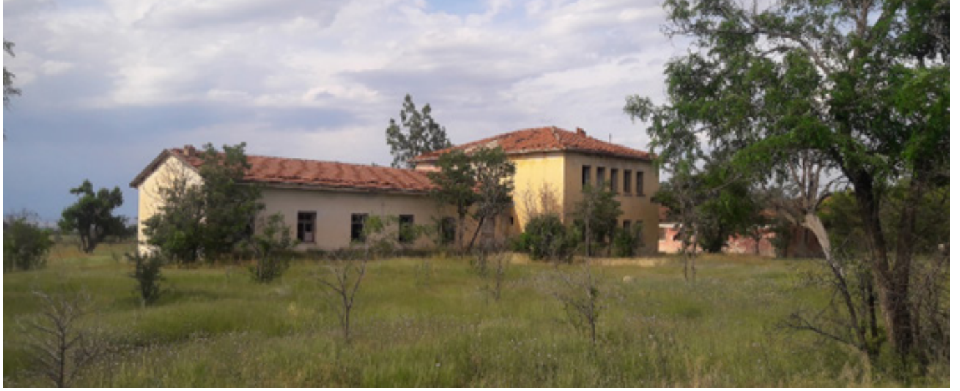
Akçadağ Köy Enstitüsü Yerleşkesi, derslik ve lojman, 2018 (Fotoğraf: Çağla Ormanlar Ok, Tekben Arşivi).
